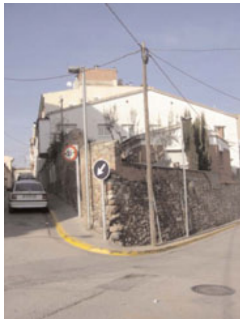
Can Maset, carrer Barcelona. Paret feta amb còdols, probablement de les terrasses del Tenes.
