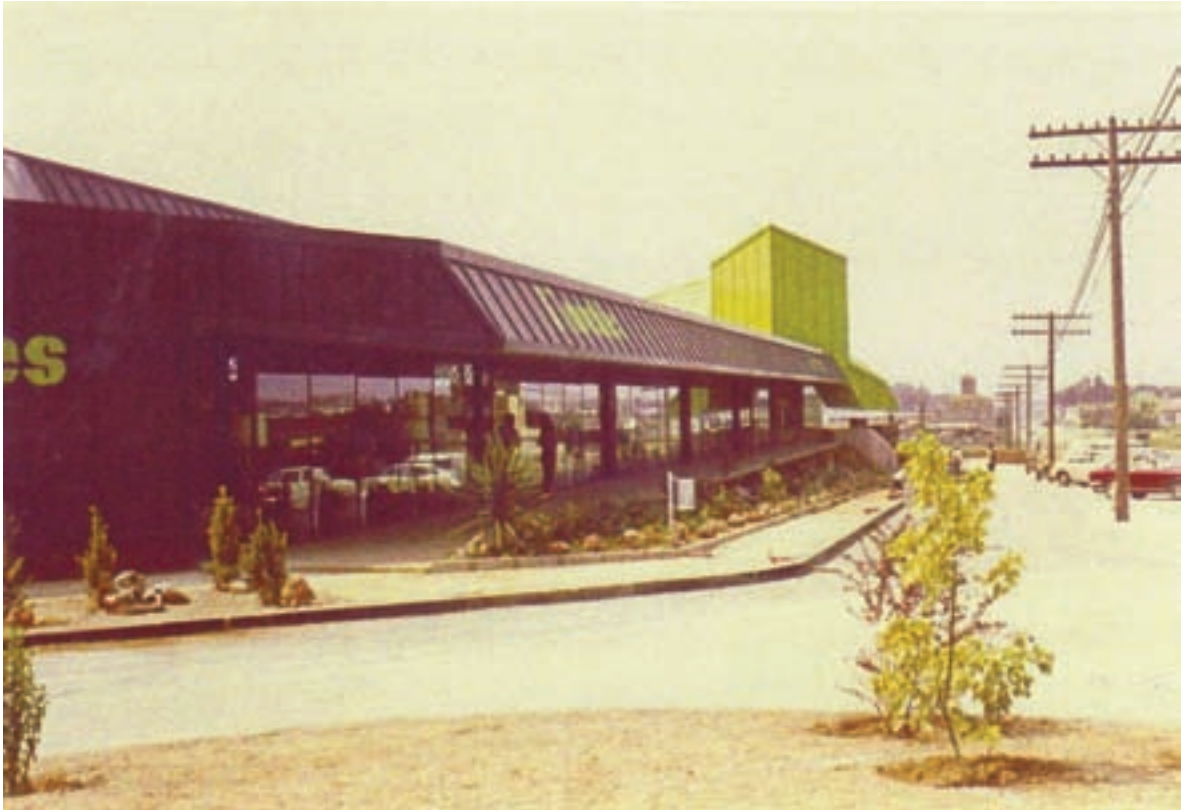
Detall de la façana exterior de TS2 Muebles, any 1972
